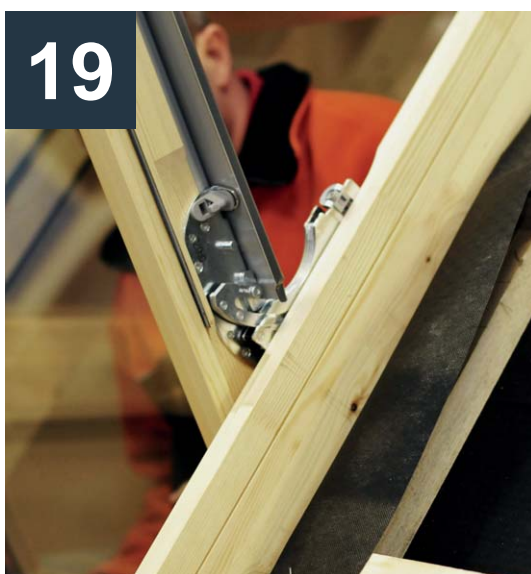
Okenní křídlo osadte do kování v rámu a zkontrolujte, jestli se volně otevírá a zavírá.
