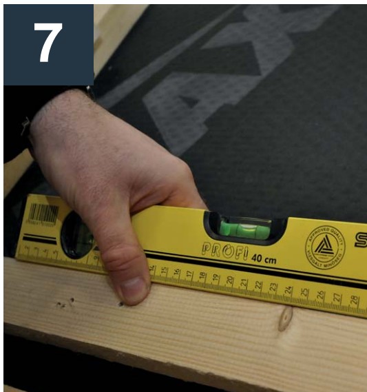
Kotvení montážní latě.
