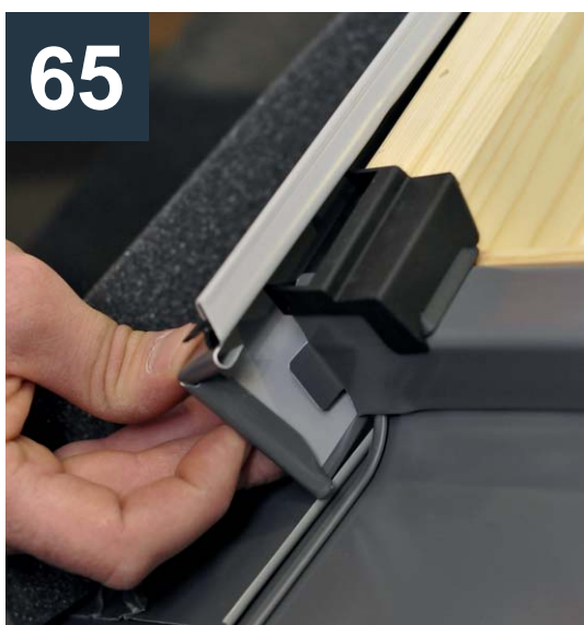
Boční díl lemování vsuňte na rám okna.
