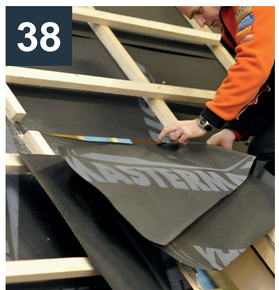
Nařízněte stávající zabudovanou folii nad rámem okna tak, aby bylo možno pod ní vsunout připravené pásy folie.
