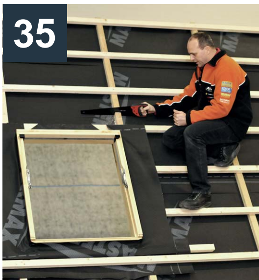
Je nutné, aby jste horní pás folie podsunuli pod již zabudovanou střešní folii.
