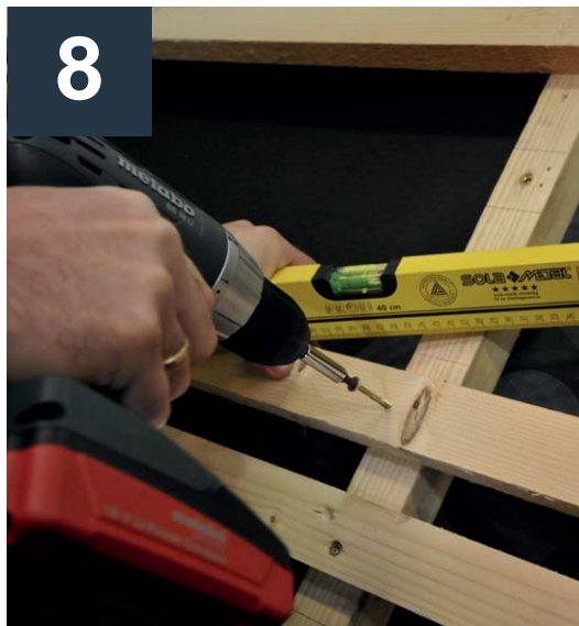
Po zaměření přesné výšky osazení okna je nutno ukotvit lať pro podepření rámu.
