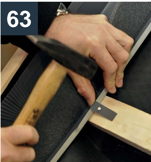
Přikotvěte boční části oplechování do latí pomocí dodaných montážních úchytů.
