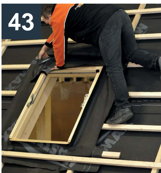
Spodní pás přisponkujte do rámu střešního okna.
