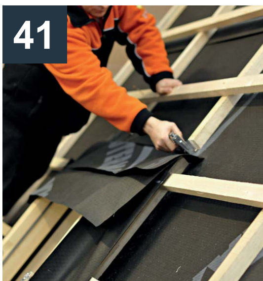
Podsunutě pásy ukotvíte.
