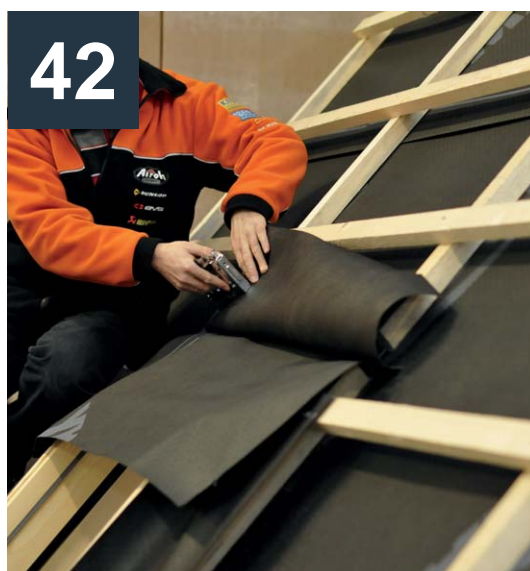
Horní pás folie přisponkujte do latě nad místem řezu.
