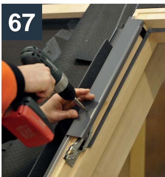
Osadte horní krycí plech křídla.
