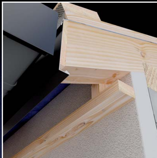
Montáž rámu pro fixaci obkladu.
