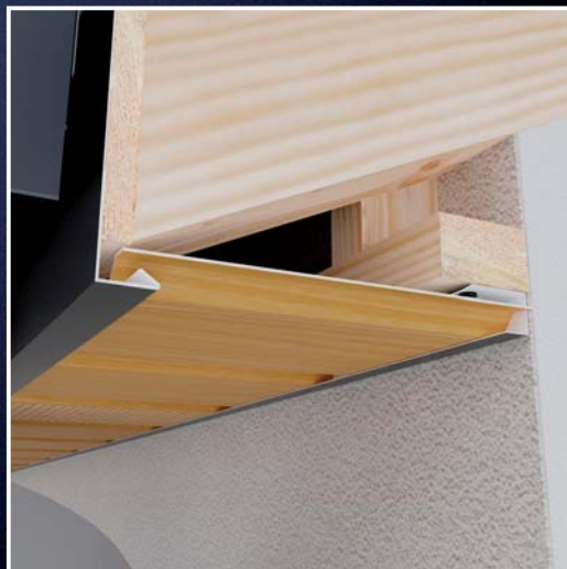
Obklad namontovaný na klempířských prvcích.
