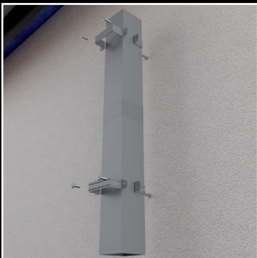
Montáž svodu v objímkách, spojování svodu svodovou spojkou
