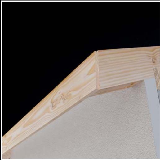
Příprava pro montáž okapového systému a střešní krytiny.
